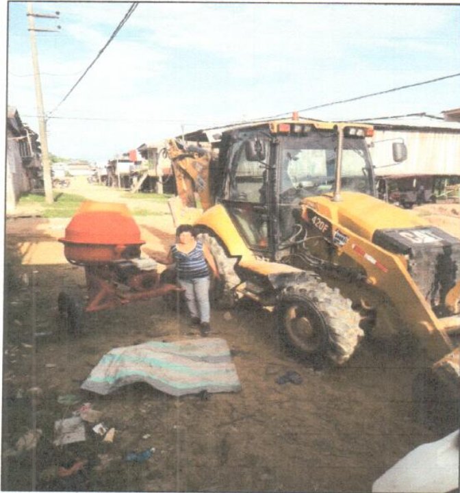
Imagen N°17: Recepción de maquinaria pesada denominada "Retroexcavadora"
