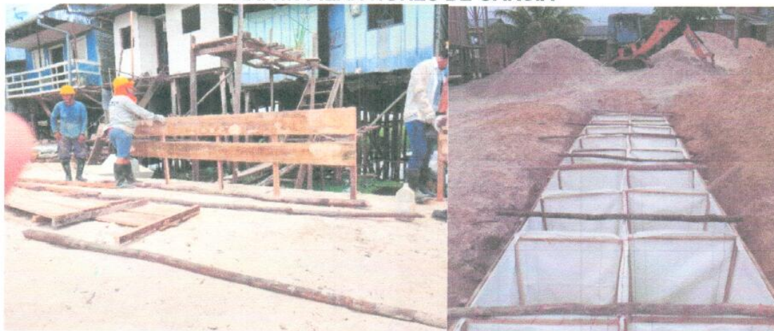
Vista panorámica: donde se observa el armado de encofrado para BIGBAG.
