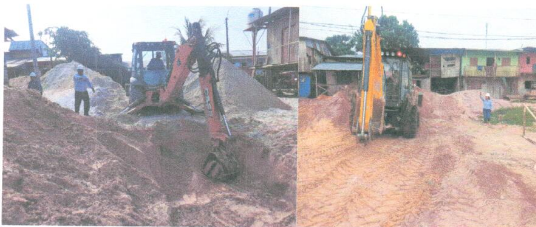
Vista panorámica: donde se observa los trabajos con retroexcavadora
