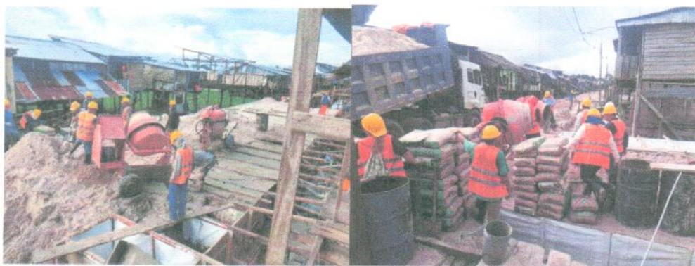
Vista panorámica: donde se observa vaceo de mortero en BIGBAG
