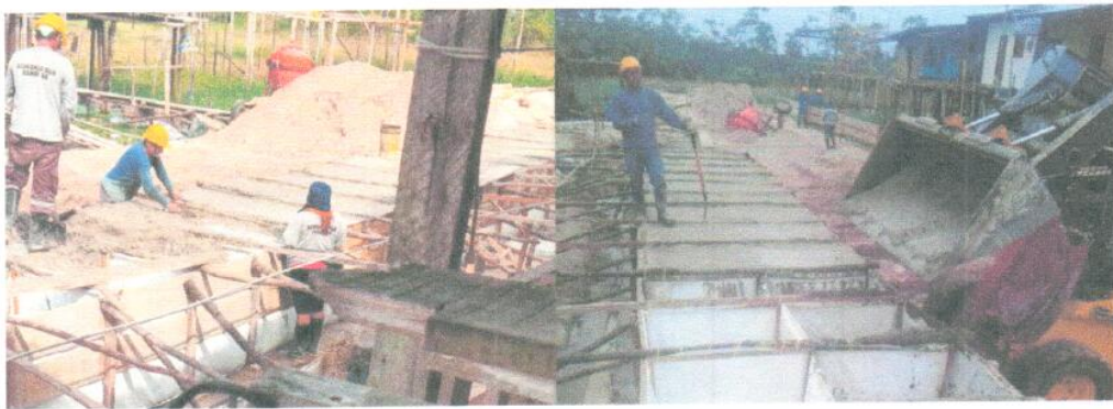
Vista panorámica: donde se observa vaceo de mortero en BIGBAG.
