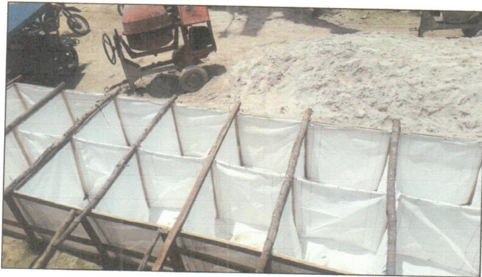
Imagen N°14: Instalación de big bag en calle alianza, con dimensiones de 1m. x 1m.x 1m.
