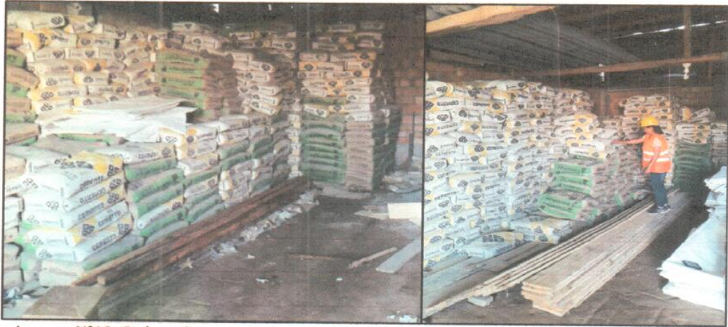
Imagen N°19: Orden y limpieza en almacén, se procede con la recepción y ordenamiento de bolsas con cemento.
