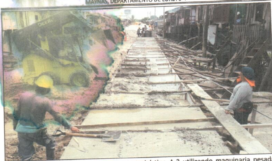
Imagen N°38: Trabajo de relleno con material tipo A-3 utilizando maquinaria pesada "Minicargador".
