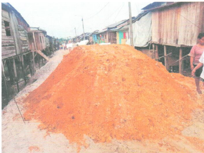
Vista panorámica: donde se observa el abastecimiento de material A-2-4
