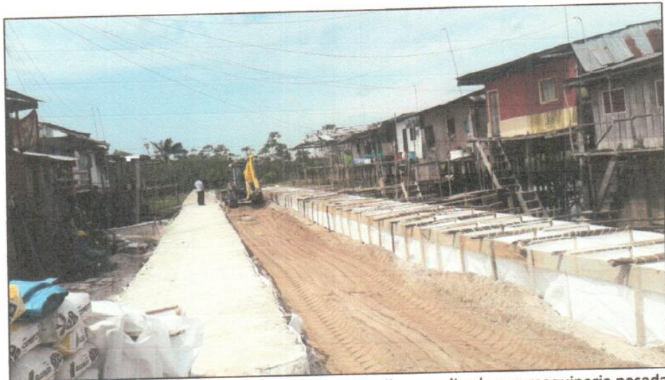
Imagen N°35: Trabajos de acopio de material de relleno realizado con maquinaria pesada "Retroexcavadora", ubicado en calle soledad.
