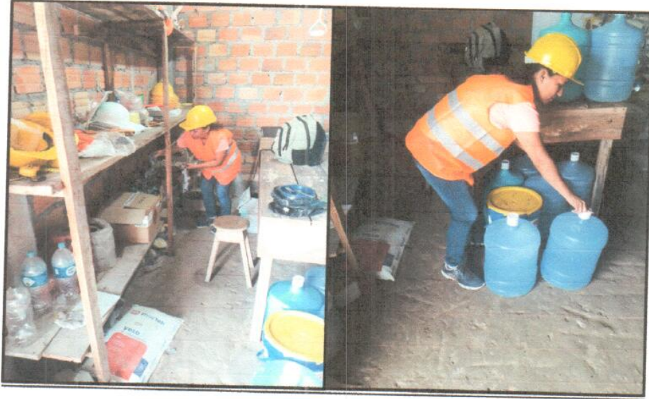
Imagen N°01: Se inicia las actividades con la recepción de materiales y herramientas a ser utilizados durante la construcción. Además se procede con las actividades de orden y limpieza dentro de almacén.
