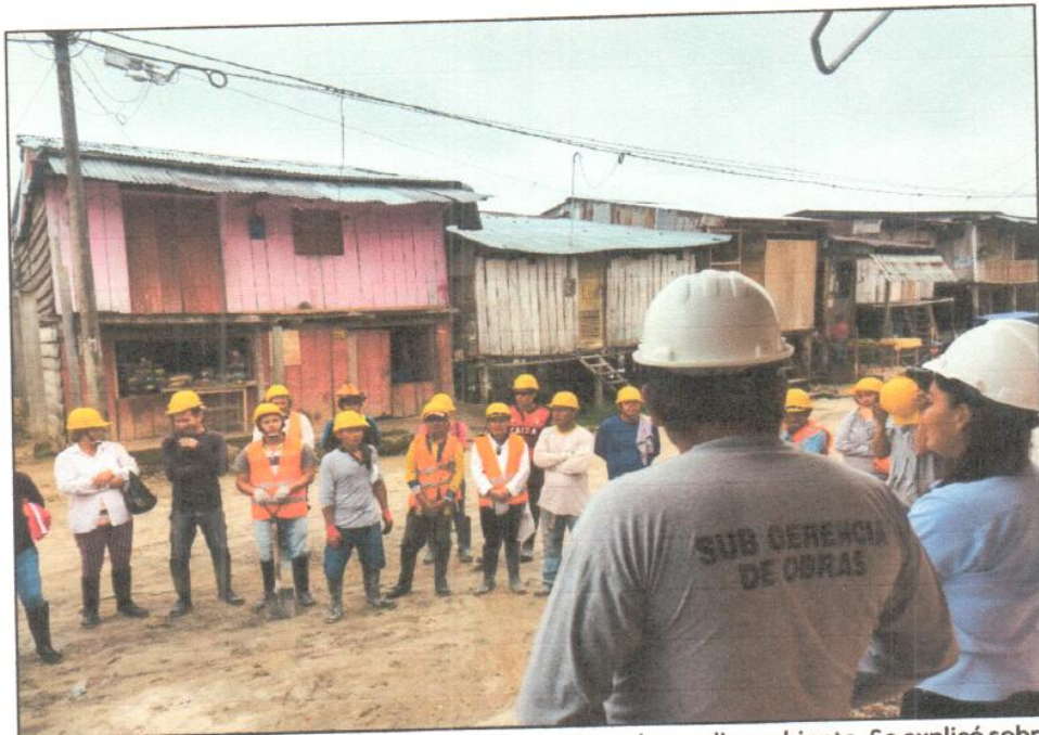
Imagen N°39: Charlas de seguridad, salud ocupacional y medio ambiente. Se explicó sobre el uso correcto de los equipos de protección personal.
