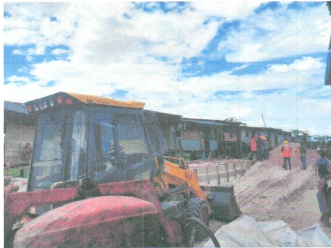
Vista panorámica: donde se observa los trabajos con retroexcavadora
