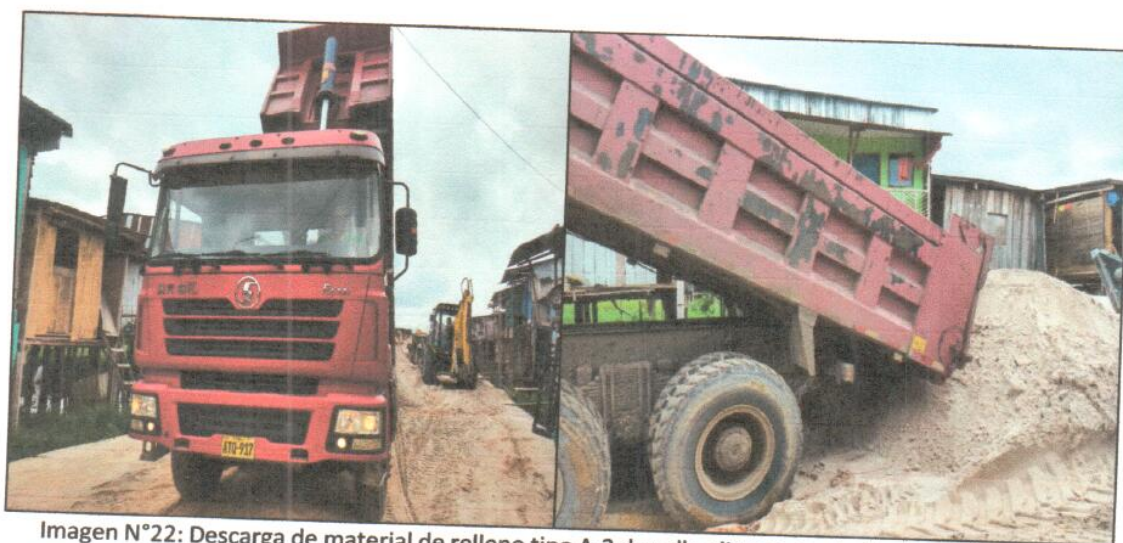
Imagen N°21: Movimiento de material de relleno tipo A-3; en las imágenes se aprecia el recubrimiento del material como medida de seguridad, con la finalidad de evitar esparcimiento de arena en la atmósfera.
