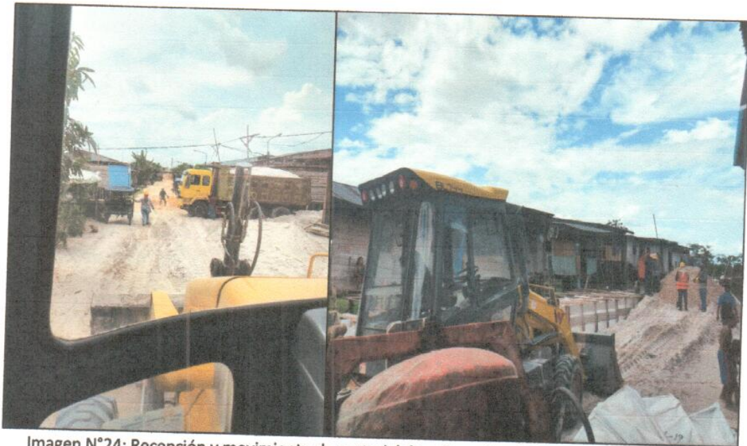
Imagen N°24: Recepción y movimiento de material de relleno tipo A-3.
